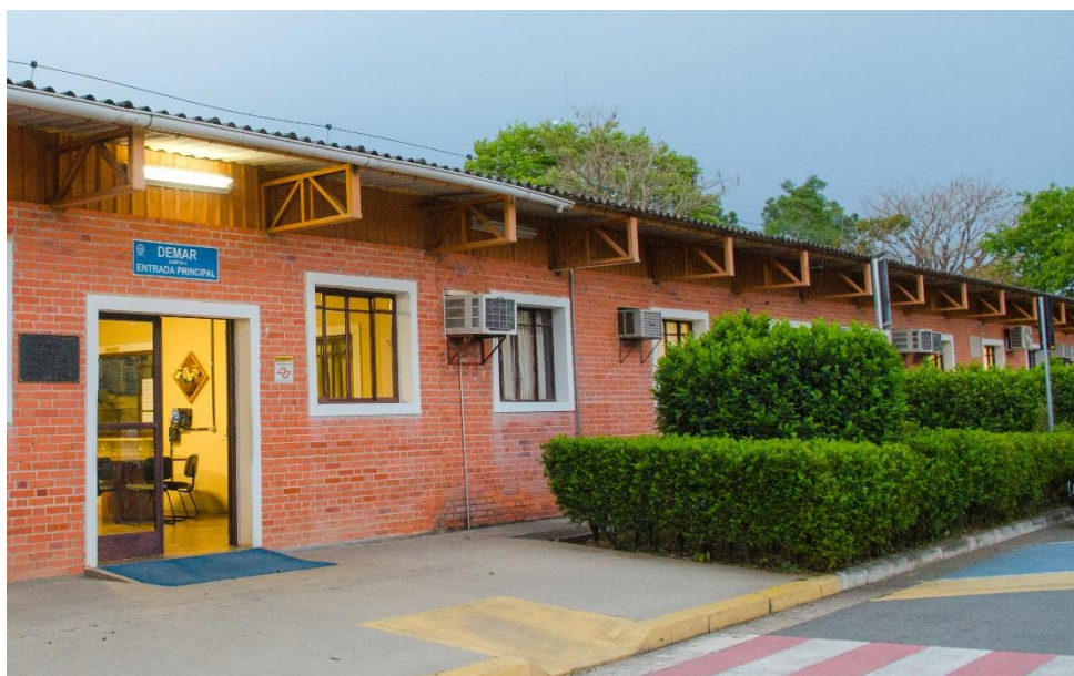
Figura 1 – Entrada do Departamento de Engenharia de Materiais.
